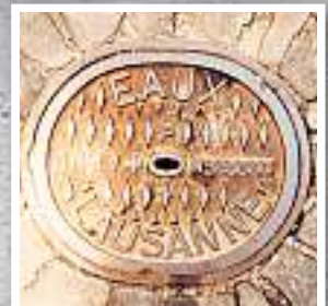
«Eaux Lausanne» – Dolendeckel zur Frischwasserversorgung in Lausanne . «Eaux» weist auf Trinkwasser (Gegensatz zu Abwasser) hin. Ovale Dolen wie diese hier, sind selten.
