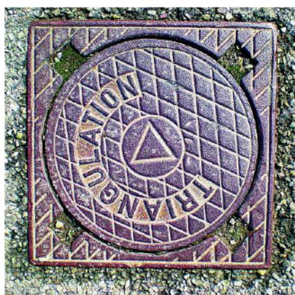
Moderner Deckel über einem Triangulationspunkt am Stausee Klingnau. LMÜ
